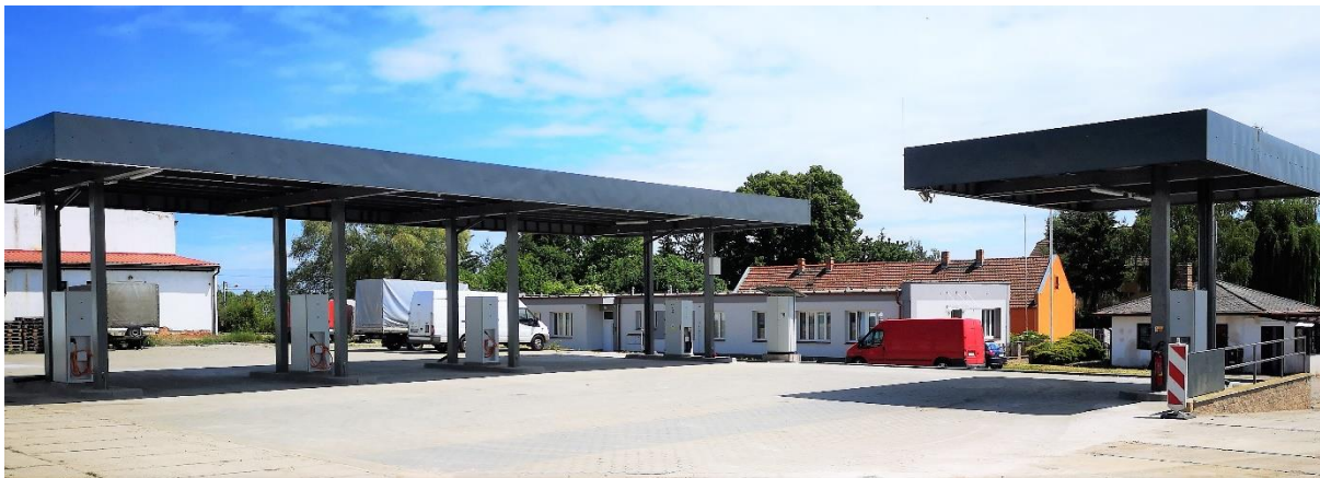
Nabíjecí stanice v bývalé cihelně v městské části Sedlec
